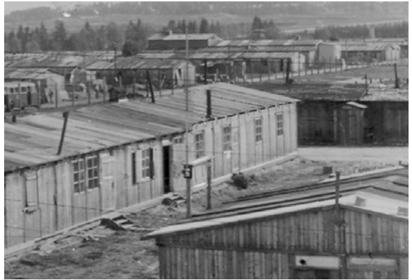
Valka-Lager in Nürnberg Langwasser
